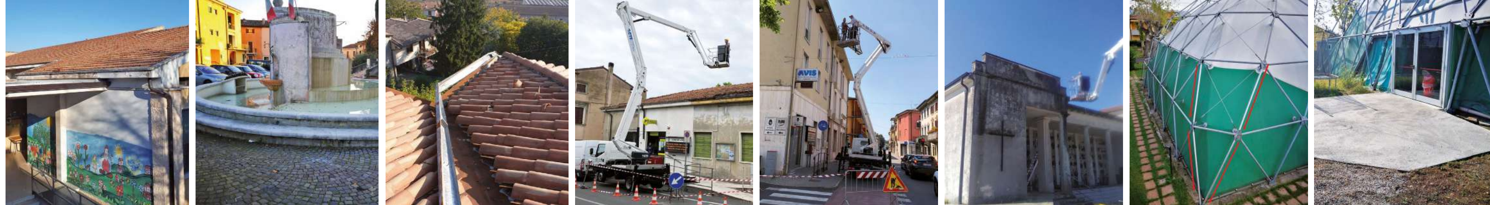
Copertura della Scuola Primaria di Palazzolo
