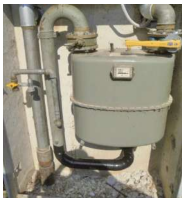
Sostituzione e Posa Contatori
