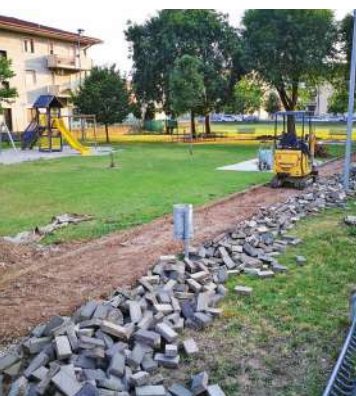
Lavori al Parco Tortella - Lugagnano
